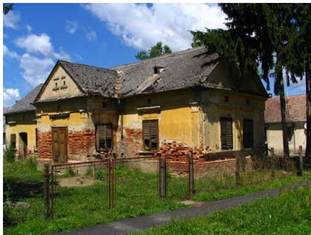
Megvásárlásra és felújításra váró somogyi parasztház. Most csak bagolylak. (Fotó: Klein Ákos)
